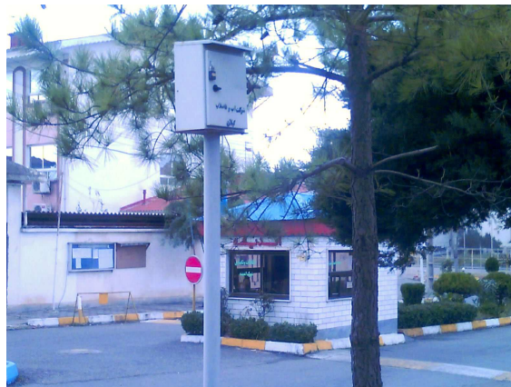
شکل(4): فشار سنج های قرائت از راه دور در شهر رشت
