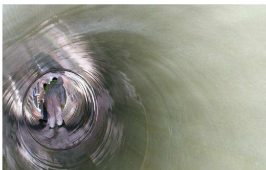
شکل (2): لاینینگ پلی استر از طریق تزریق آب داغ پر فشار
