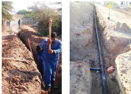
شکل (۵): تصویری از اصلاح و بازسازی شبکه توزیع آب شهر هرمز
