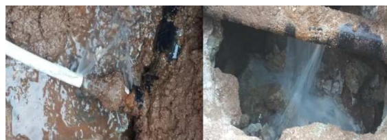
شکل (۸): نمونه ای از کشف نشت در شبکه و انشعابات آب
